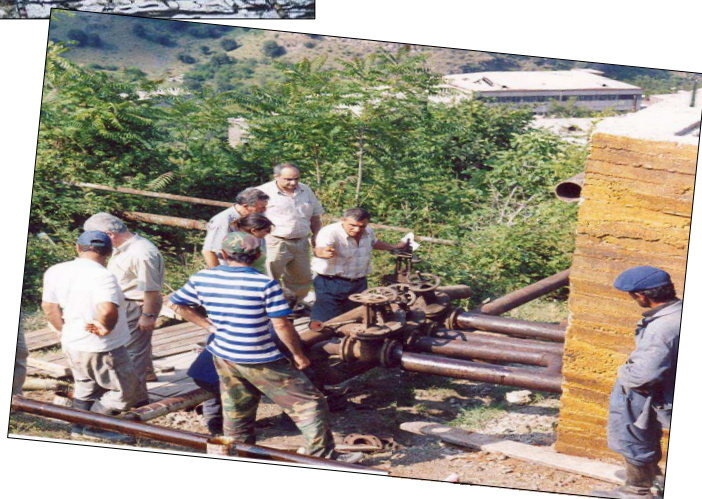
Αντικατάσταση ανακαίνιση κυρίων αγωγών διανομής δικτύου ύδρευσης της Κοινότητας Yaghagan.
